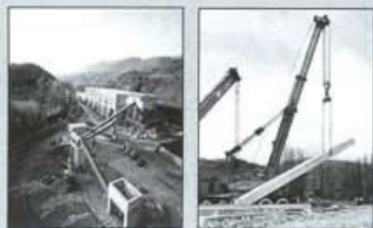
1971 posa del primo pilastro dello stabilimento
