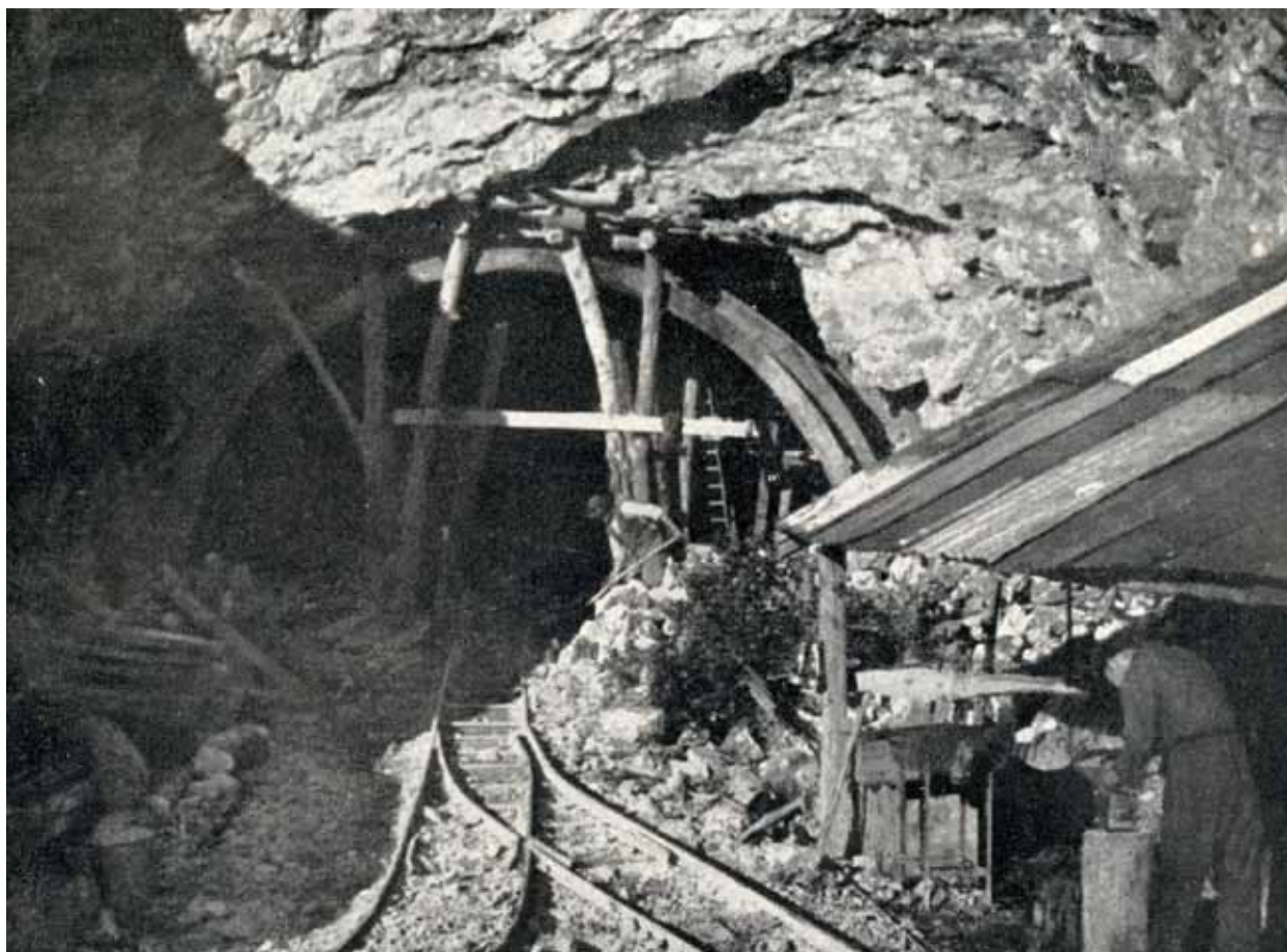
Lavori in corso nella galleria Belvedere
